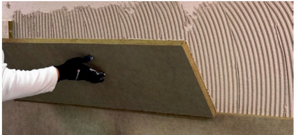
Anschließend die Dämmplatte am vorbereiteten Untergrund andrücken und einschwimmen. Es ist kein Verdübeln erforderlich. Foto: Heck Wall Systems
